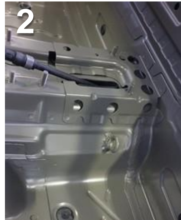
Anclaje lateral derecho
