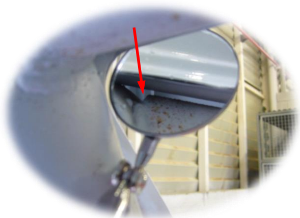
Tubo sin soldar en la unión
