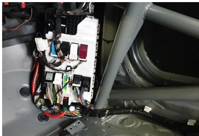
Nueva disposición de la central de conexiones
