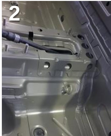
Anclaje lateral derecho
